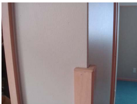
＜図表 4-7 安全に配慮したコーナー＞ 角があると危ないので、要所にコーナーカバーを設置している。
