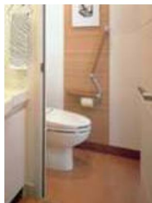
図6 トイレ手すり
