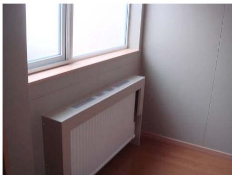
＜図表 4-6 保護された暖房機＞ 火災や触ってやけどしてしまうことを避けるために保護されている。
